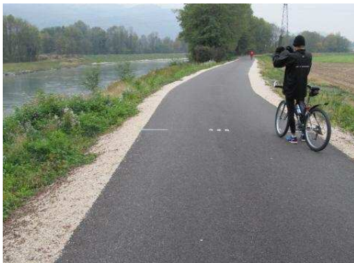
Piste cyclable en sommet de digue
