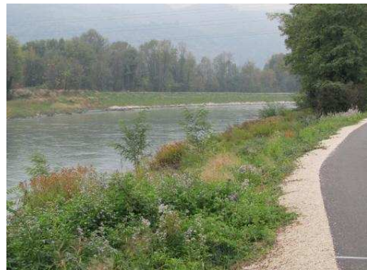
enrochement dans les courbes du cours d'eau
